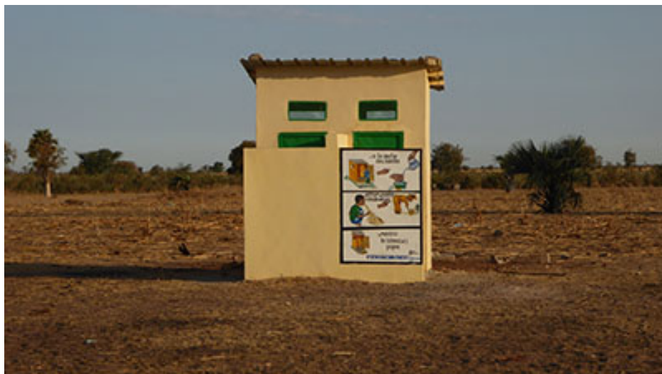
Un bloc de latrines publiques
