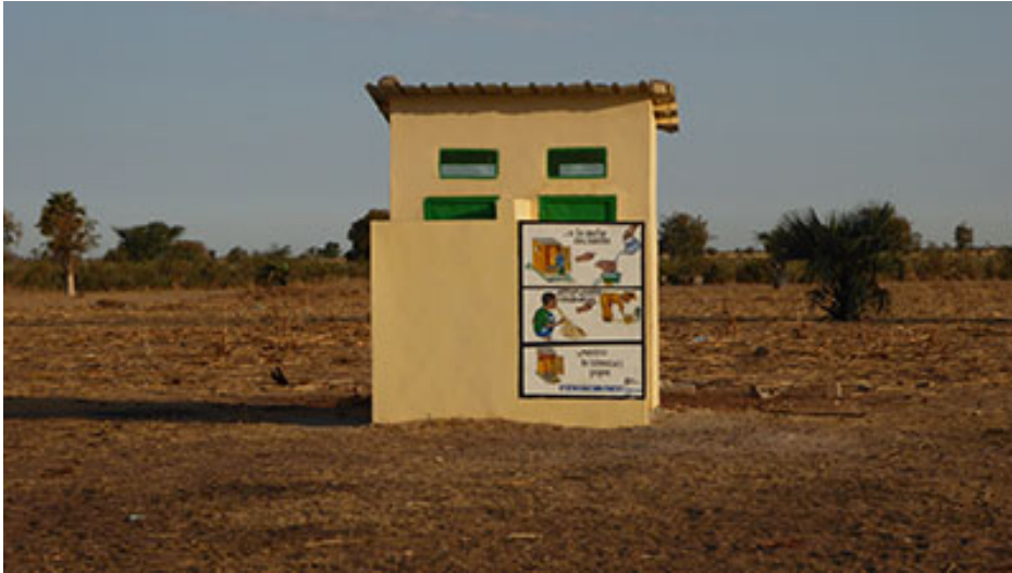
Un bloc de latrines publiques
